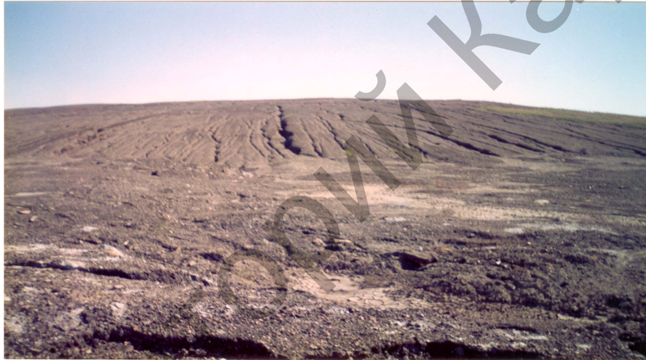
Рис. 1. На склонах отвала – проявления струйчатой эрозии.
