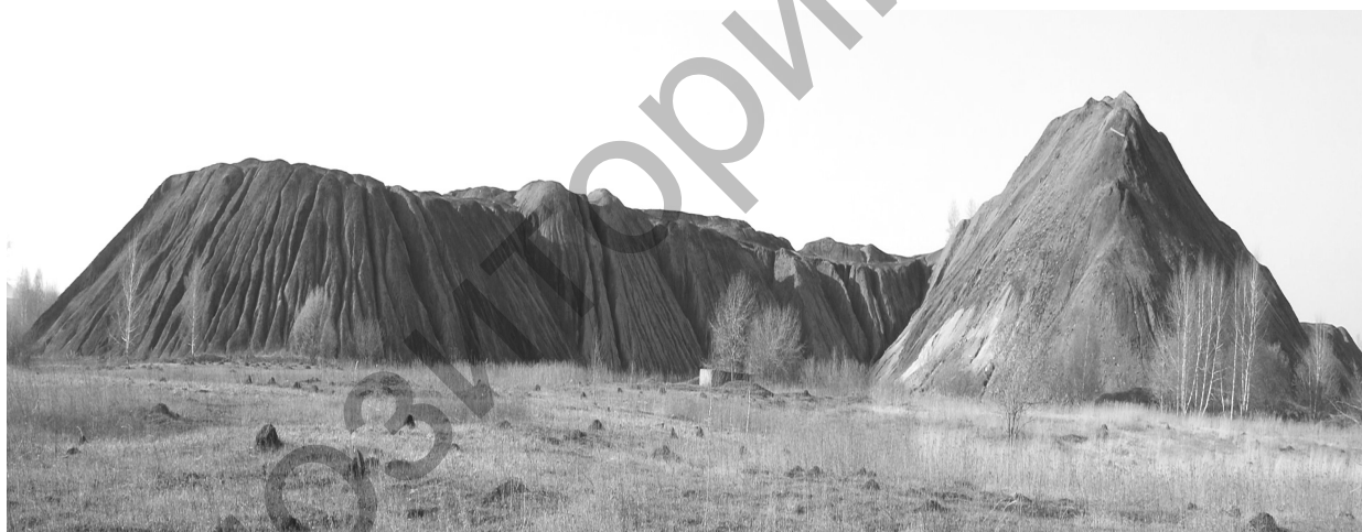
Рисунок 2. Терриконы складирования надугольных вскрышных и «пустых» пород на одном из месторождений Мосбасса, не зарастающие вследствие токсичности сульфидоносных толщ, изъеденные сетью водороев до состояния bad lands (фото А.Шараповой)
