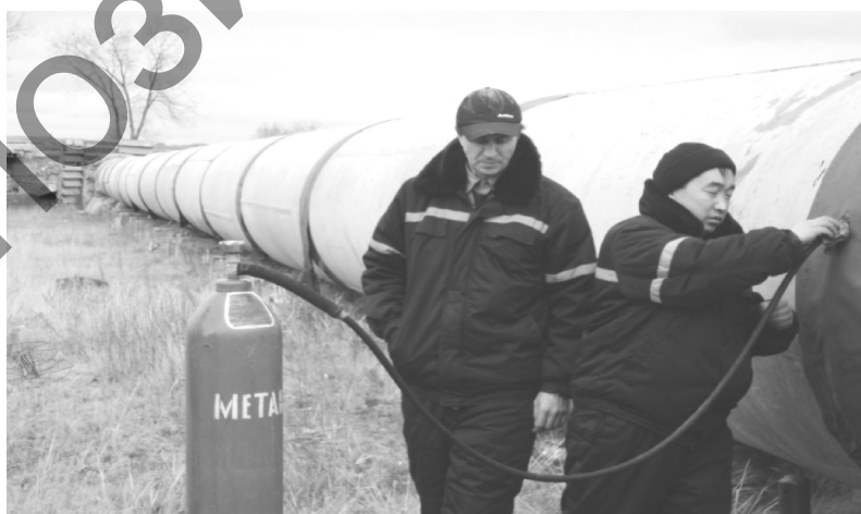
Рисунок 1. Момент загазирования ударной трубы метаном
