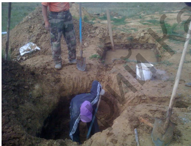
Сурет 2.16 – Бұрғылау суларына арналған шұңқырды дайындау
