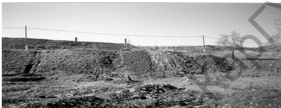
Рисунок 6. Террасированная поверхность, сложенная отработанной породой. На склонах – проявления струйчатой эрозии [8].
